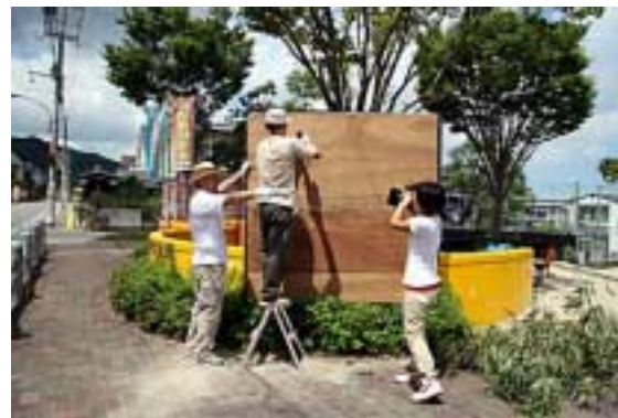
(2)設営04(看板組み立て)
