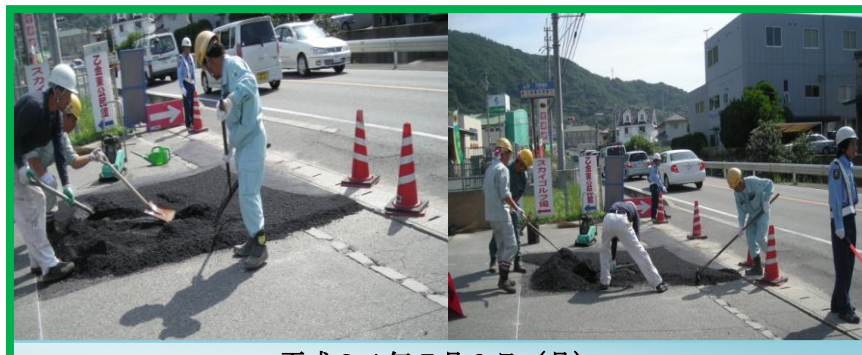
平成24年7月9日(月) 大野城飯塚線の乙金東区公民館入り口段差解消のため福岡県より工事着手
