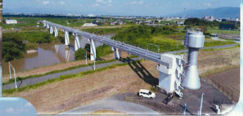
思案橋水管橋
