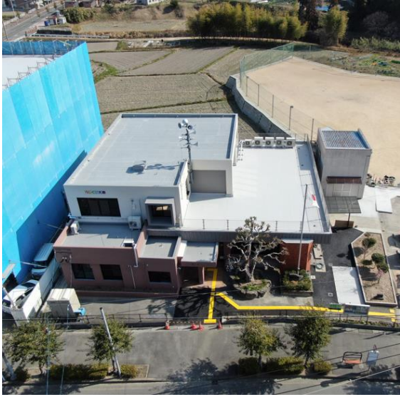
ドローン撮影による全景
