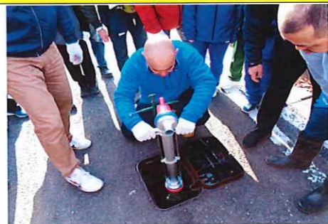
差込み金具を消火栓へつなぎ方説明
