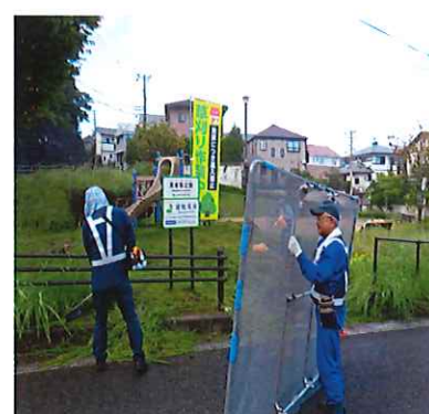
6丁目長者原公園 防護ネットで安全確保
