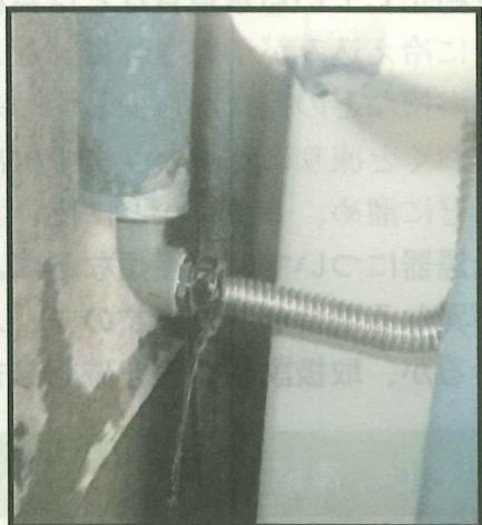
平成 28 年 1 月に福岡を襲った寒波による水道管・給湯器などの凍結破損で、漏水が多数発生しました。
