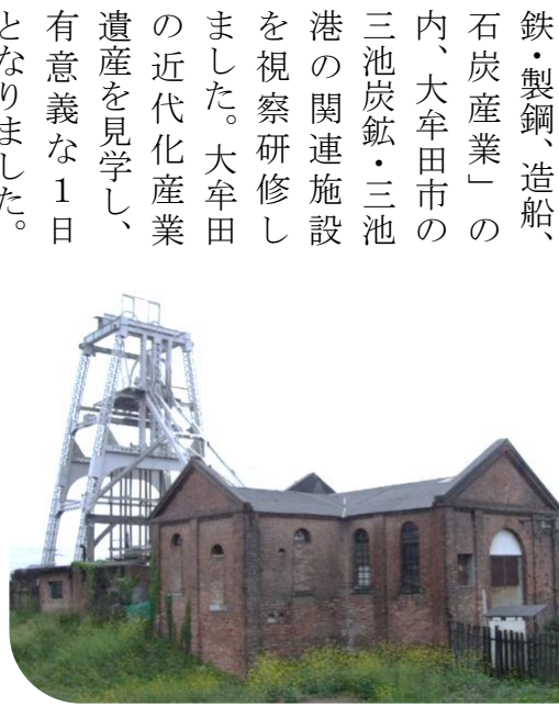
宮原坑：最古の鋼鉄槽（明治34年築）
